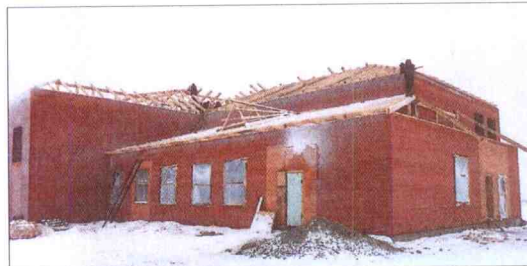
■ Активно ведётся строительство детского сада в деревне Камышево. Жители с гордостью заявляют, что это первый в истории деревни настоящий детский сад. Раньше дошкольные учреждения размещались в приспособленных помещениях.
